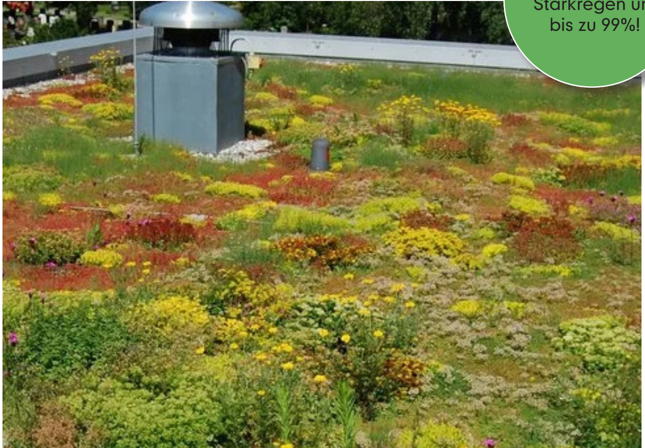
Abb. 3: Beispiel für ein Retentionsdach; Bildadresse: https://www.optigruen.de/fileadmin/_processed_/4/8/csm_Mean-der60_Header_2560x800_d3c1f35cc7.jpg
