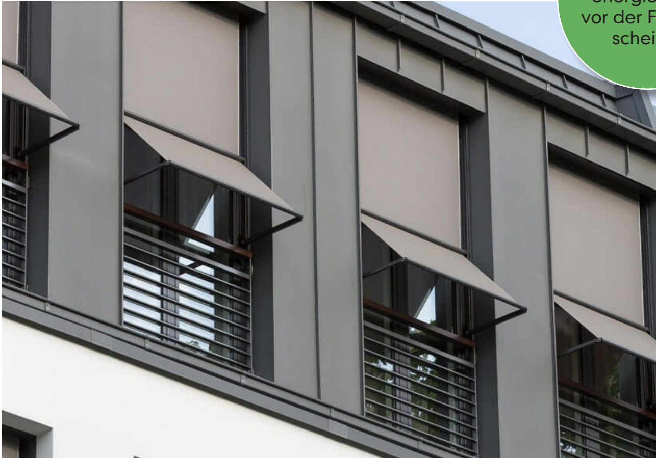
Abb. 8: Beispiel für einen außenliegenden Sonnenschutz; Bildadresse: https://www.schmidt-sonnenschutz.de/wp-content/uploads/2020/01/schmidt-sonnenschutz-markisoletten-min.jpg
