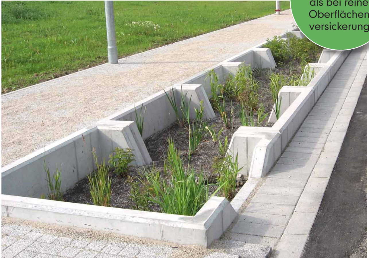
Abb. 17: Beispiel für ein Mulden-Rigolen-System; Bildadresse: https://beton-mueller.de/wp-content/uploads/2021/02/mulden-rigolen-bodenfilter-3-1.jpg
