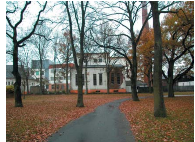
Projekt 1 Gelände Hofgarn, nördlicher Teil (vor Abriss)
