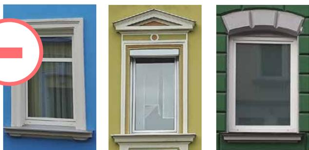
Fehlende und vorgetäuschte Fensterunterteilung, innenliegende Sprossen, aufgesetzter Rollladenkasten
